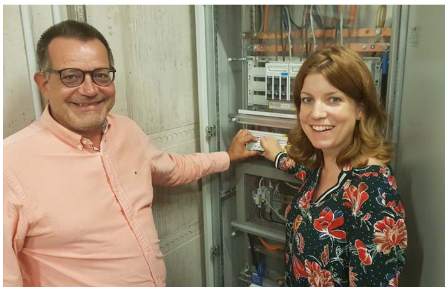
Inbetriebnahme Photovoltaik-Anlage 24. August 2021
